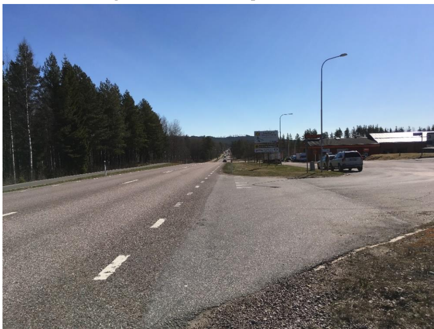
Figur 5. Korsning E16/OKQ8, sett västerifrån (foto: ÅF)
