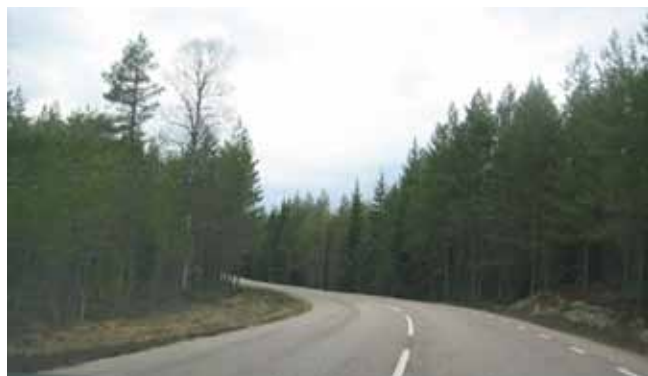
E16 norr om Lekvattnet, Sverige. Riktning mot väster.
