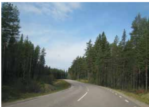
E16 söder om Mårbacken, Sverige. Riktning mot väster.
