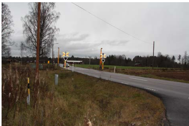
Järnvägsövergång för E16 vid Hulån.
