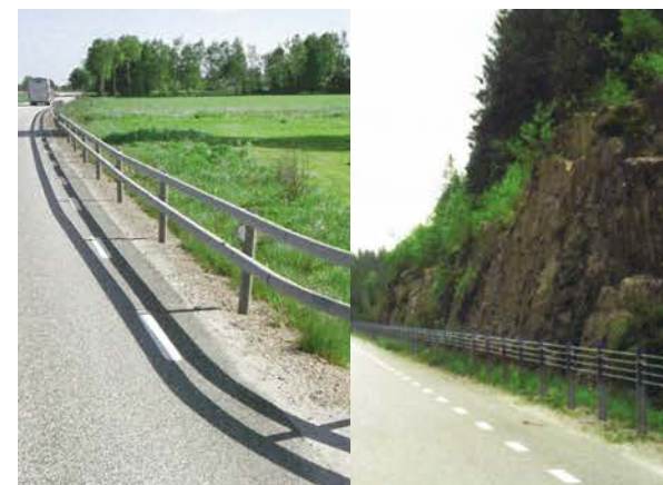
Rörräcken och ställineräcken är exempel på räkestyper som båda har god genomsikt. Källa: Vägen, en bok om vägarkitektur.
