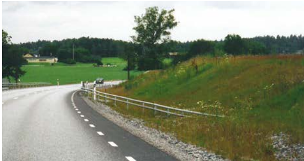
Räckesändan svängs ut och förankras i bakslänten, en både trafiksäker och estetiskt tilltalande lösning. Källa: Vägen, en bok om vägarkitektur.
