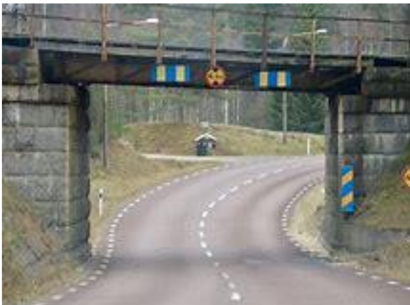
Figur 14. Trång sektion strax norr om Yttermalung. Låg och smal passage under järnvägen och i kurva – litet av en skräckpassage för många lastbilschaufförer.
