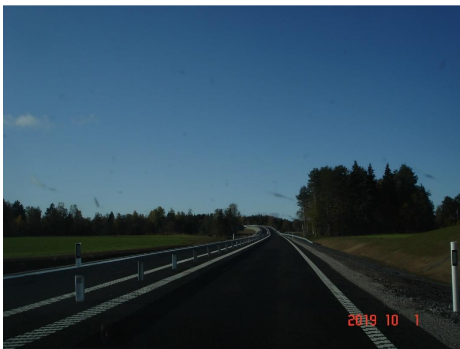
Figur 24. Exempel på hur den nya sträckningen av E16 på delen Vansbro – Dala Järna utformats. Öppnades för trafik under hösten 2019.
