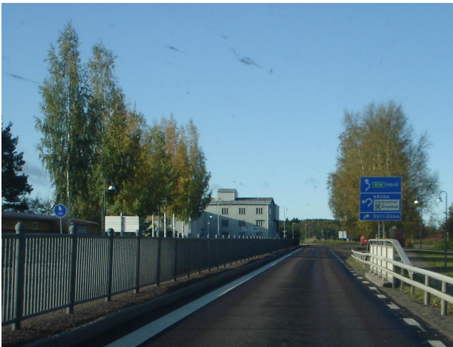
Figur 35. E16 i Djurås strax före anslutande väg mot Bäsna. Mötesseparering och bländskydd.
