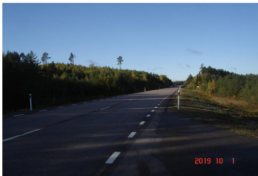
Figur 29. Mellan Björbo och Dala – Floda är sektionen till stor del 9-metersväg.
