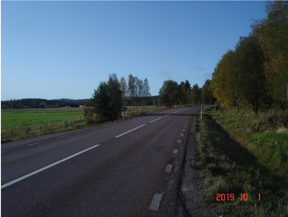
Figur 31. På den aktuella sträckan fram till Mockfjärd är vägsektionen smal – i huvudsak 7-metersväg.
