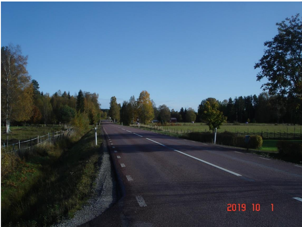
Figur 32. På den aktuella sträckan fram till Mockfjärd är vägsektionen smal – i huvudsak 7-metersväg.
