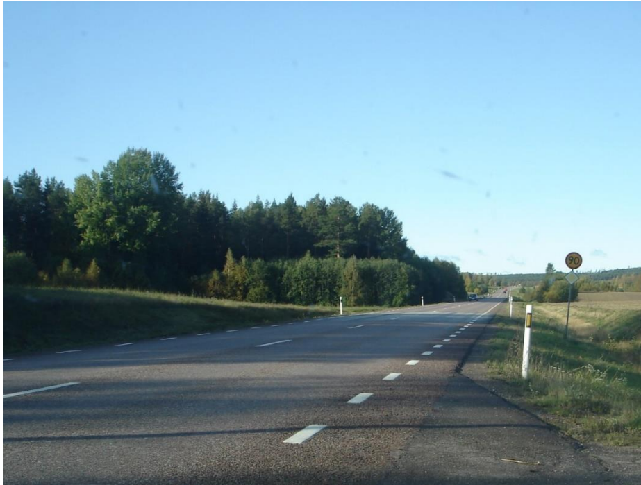
Figur 36. E16 väster om Djurås mot Mockfjärd. I huvudsak goda förutsättningar för att bygga ut till mötteseparerad väg.
